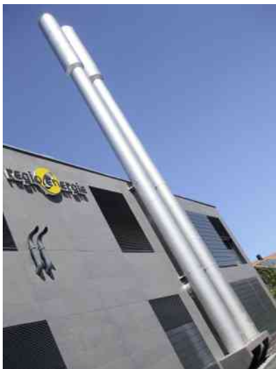
Die fertige Abgasanlage.
