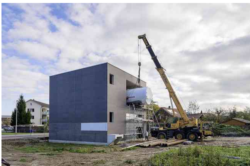
Bild aus der Bauphase: Einbringung des Gas-Heizkessels.
