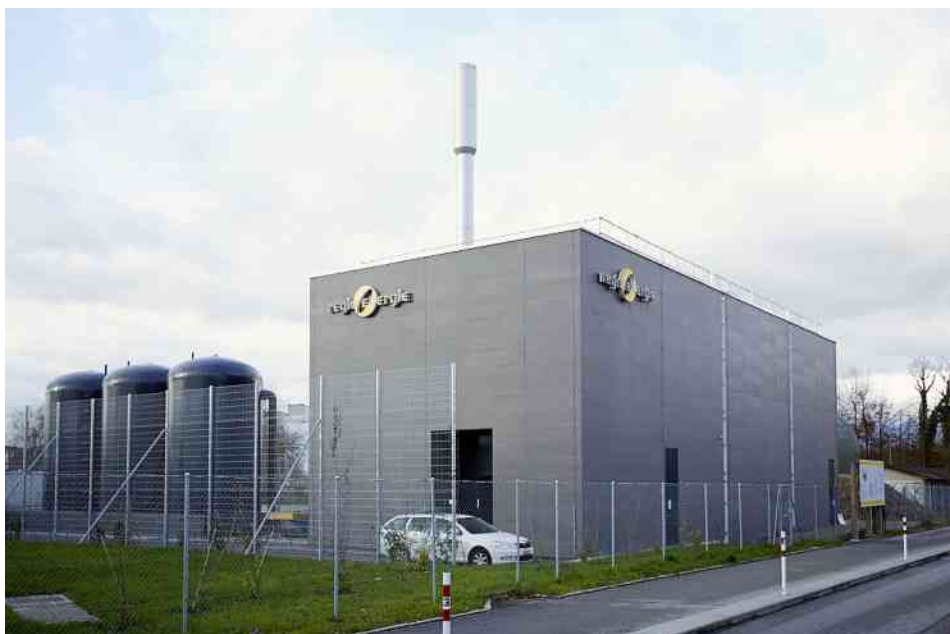
Hybridwerk Aarmatt in Zuchwil, noch während der Ausführungsphase.
