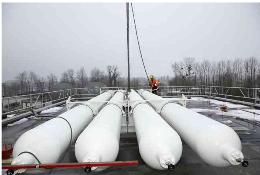
Auf dem Dach des Hybridwerks: Montage der Wasserstoffspeicher. Das Volumen von 7.5 m 3 ergibt bei 200 bar Betriebsdruck eine Speicher-Kapazität von 1500 Nm 3 H 2 à 3.5 kWh = 5.3 MWh.
